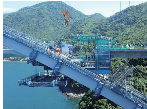
写真－3 接合桁架設状況
