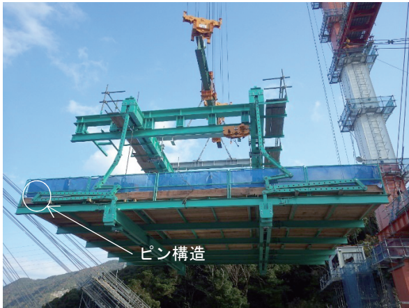
写真-1 架設状況
