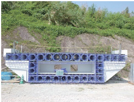
写真－2 配筋後の鋼殻セル
