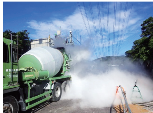
写真－4 液体窒素の噴射状況
