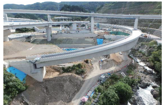
写真-6 完成状況
