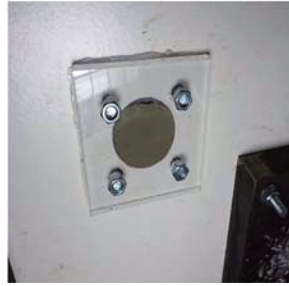
写真-3 充填確認孔
