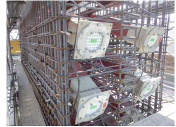
写真-1 サドル設置状況
