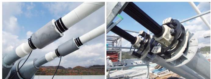
写真-4 センサー取付状況
