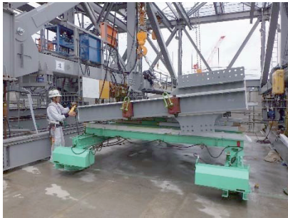
波形鋼板運搬～架設
