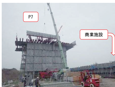
写真-2 柱頭部支保工組立て
