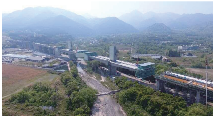
写真-9 菰野第二高架橋施工状況 (平成30年4月)
