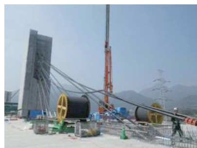
写真-3 斜材架設状況
