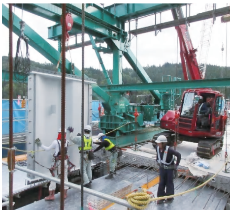
写真-3 4.9t吊クローラークレーンによる架設
