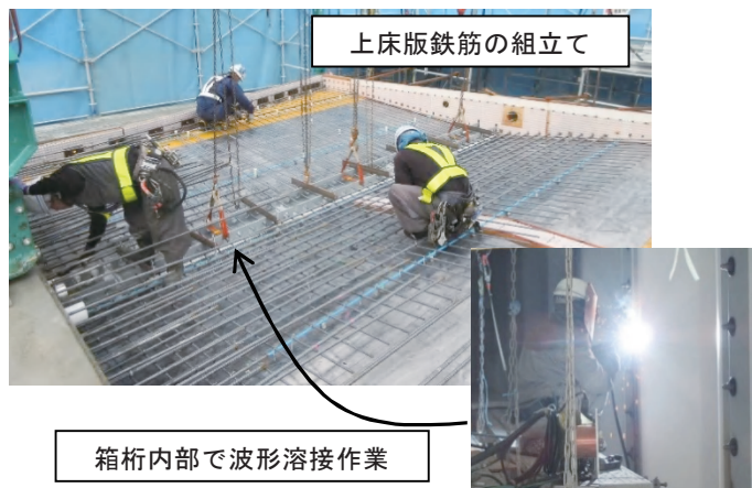
写真-4 鉄筋組立てと波形鋼板の溶接
