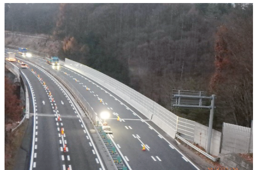
写真-3 集中工事完了時の小早川橋全景
