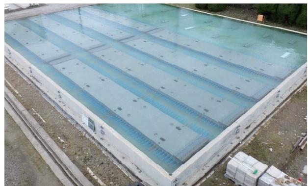
写真-2 水槽による水中養生状況
