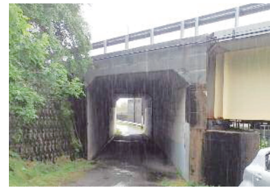
写真-1 A1 ラーメン式橋台
