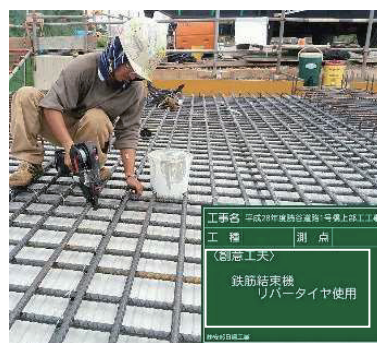
写真-2 鉄筋自動結束機
