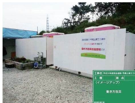
写真-4 快適トイレの設置
