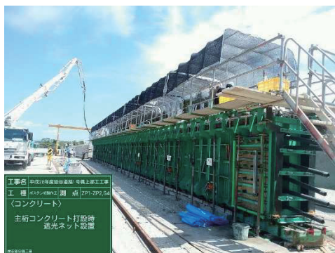
写真-3 遮光ネット設置
