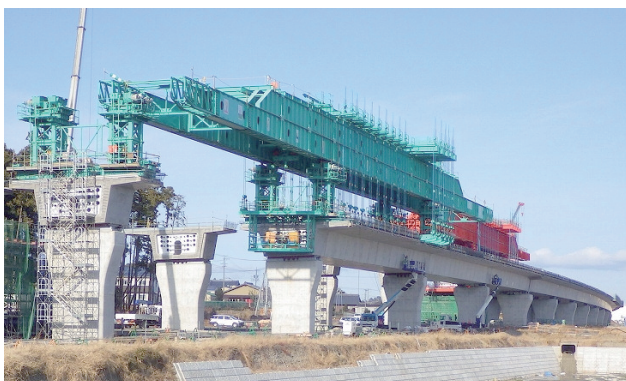
写真-1 施工状況
