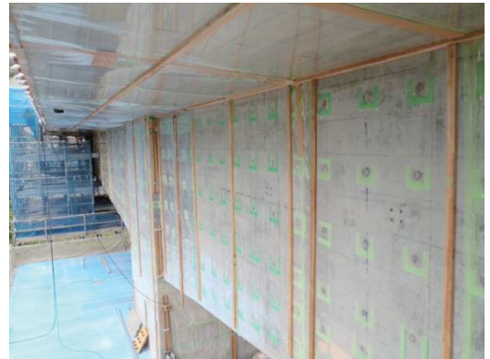
写真-2 主桁の封緘養生状況
