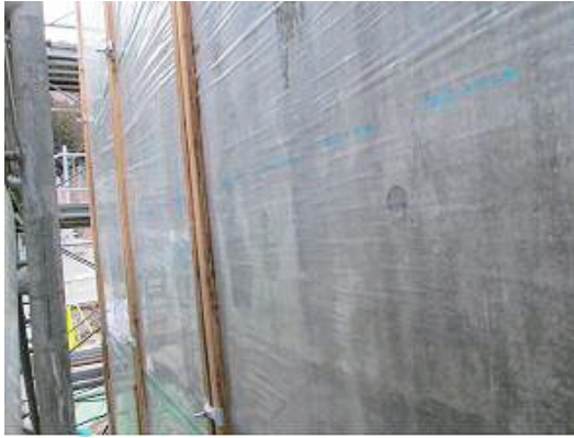
写真-1 橋脚の封緘養生
