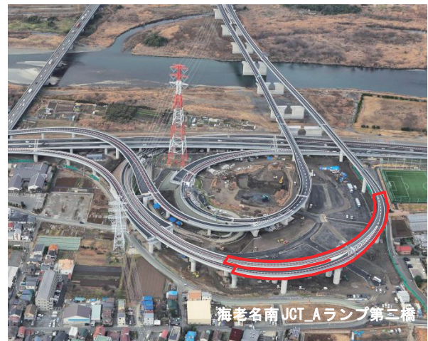
写真-4 完成写真
