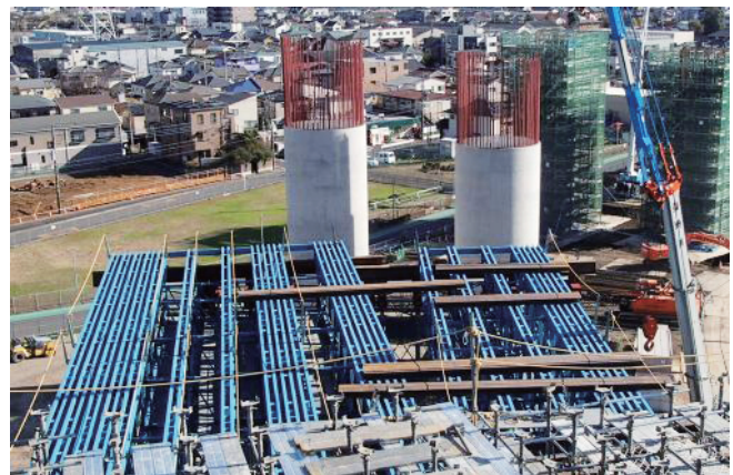
写真-3 床版受け支保工使用状況 (AP4~AP5・GP1)
