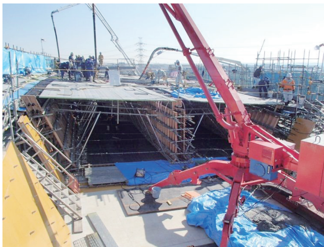
写真-1 プレッシングブームによる打設状況
