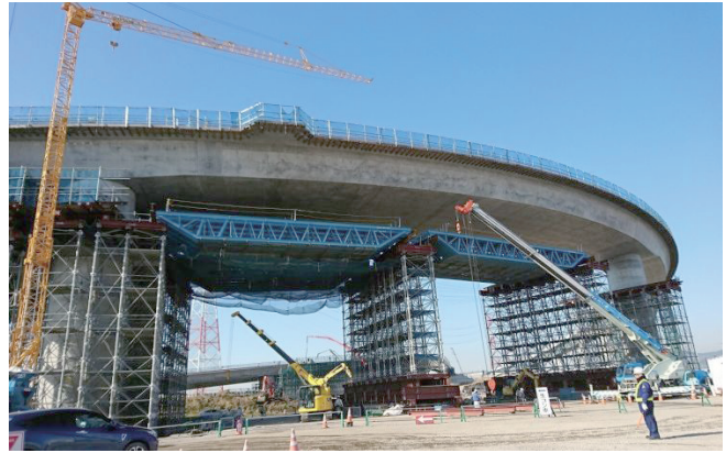
写真-2 床版受け支保工使用状況 (AP4~AP5・GP1)
