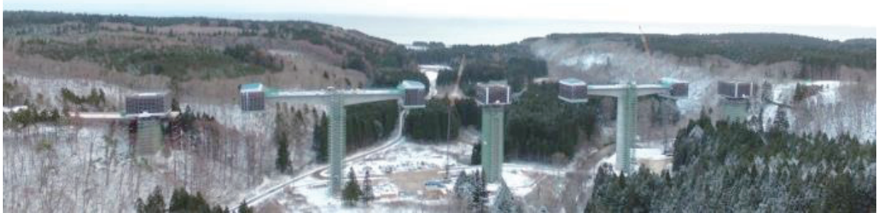
写真－1 施工状況全景写真
