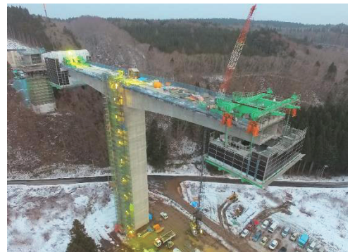
写真-5 移動作業車の解体状況
