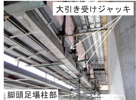
写真-3 足場建地の間隔変更
