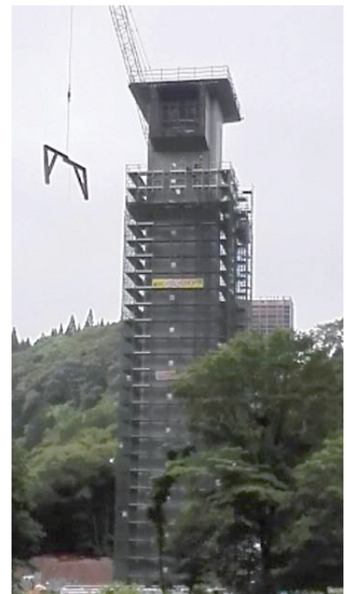
写真-4 柱頭部ブラケットの撤去
