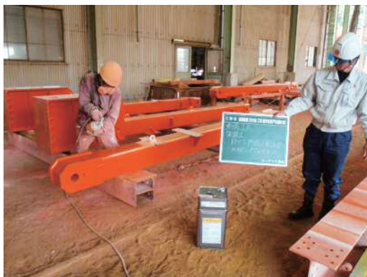
写真-3 架設機材の塗装
