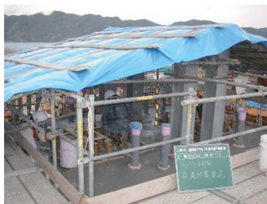
写真-6 簡易屋根による飛沫対策
