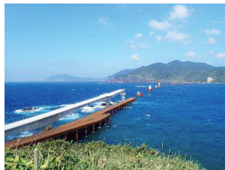
写真-7 完成写真
