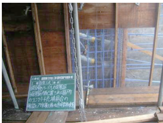
写真-5 透明型枠の使用
