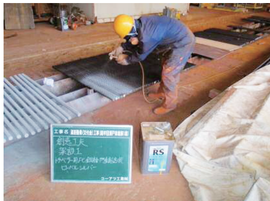
写真-4 固定アンカー防錆対策
