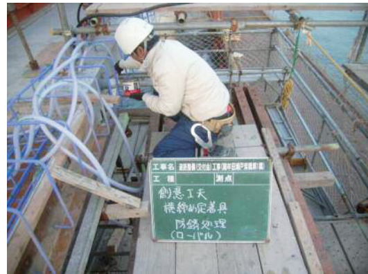
写真-2 防錆剤の塗布
