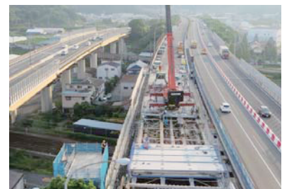
写真-1 床版更新状況
