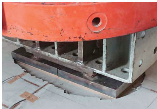
a) 載荷板付近（床版上面）
