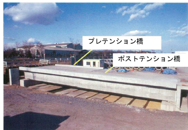
写真-2 建設時のPC橋
