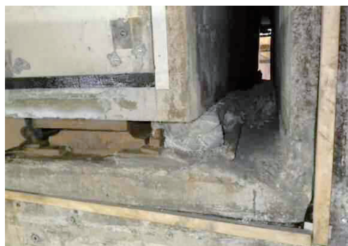
写真-2 ゲルバー遊間洗浄後
