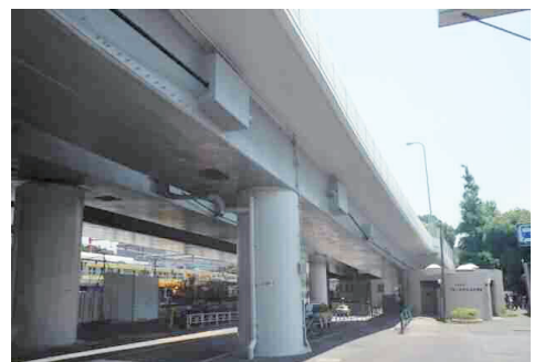
写真-3 外ケーブル配置状況
