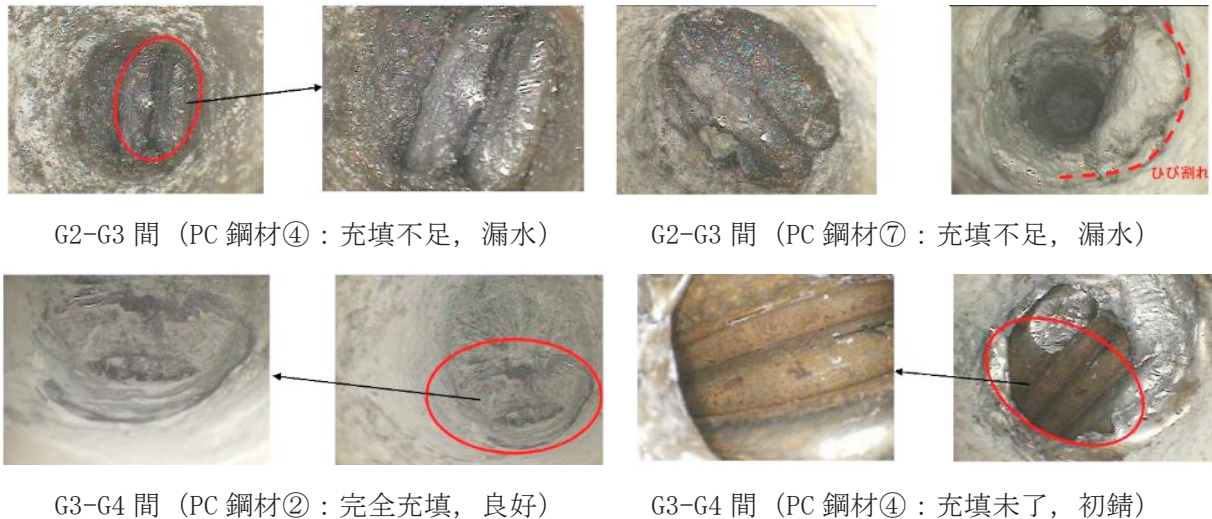
写真-3 P2支点上付近の床版連続ケーブルにおけるグラウト充填状況
