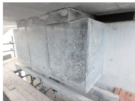
写真-7 拡幅コンクリート全景
