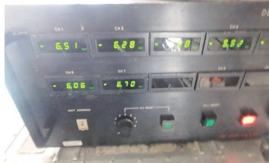
写真-2 ジャッキアップ量管理
