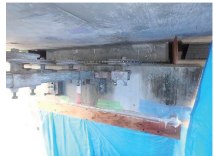
写真-5 アンカーバー切断
