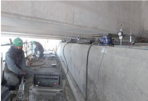
写真-1 ジャッキアップ状況
