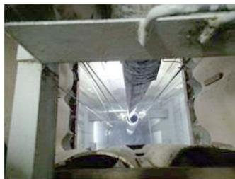
図-7 高流動コンクリート打設状況
