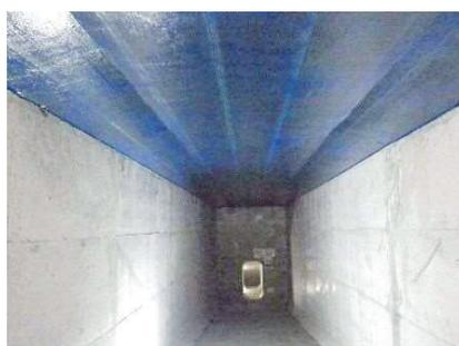
写真-6 箱桁内部補修完了
