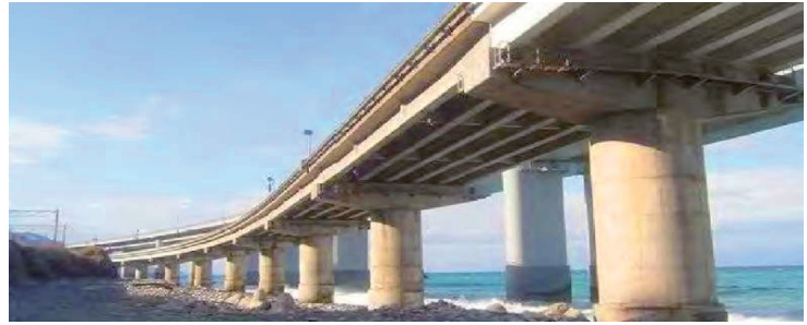
写真-1 橋梁外観 (G6 桁が海側)
