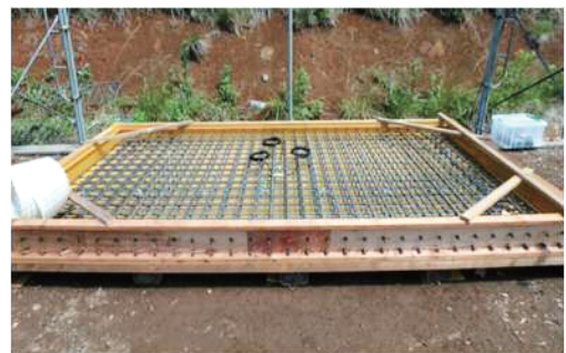
写真-1 模擬床版の配筋状況
