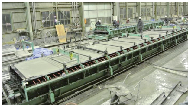
写真-1 試験部材の製造状況
