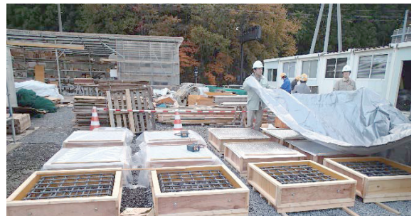
写真-1 床版養生の状況
