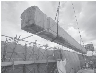
写真-4 桁撤去状況
