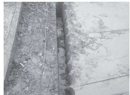
写真-5 遊間部連孔削孔
