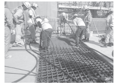
写真-11 連結床版打設
