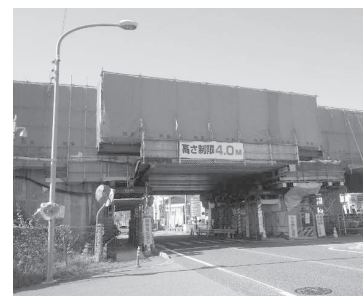
写真-2 桁下防護
