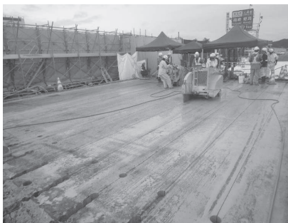
写真-3 桁切断状況
