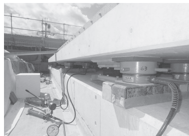
写真-7 横梁保持ジャッキ
