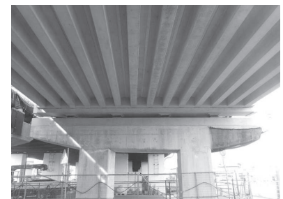
写真-13 完成 (桁下)
