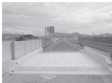
写真-12 完成 (橋面)
