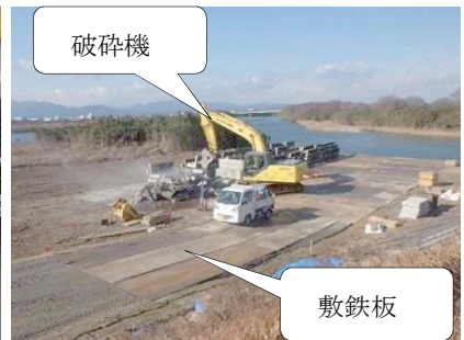
写真-8 破碎ヤードの鉄板養生
