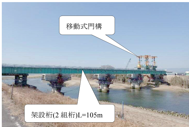
写真-3 架設桁と移動式門構
