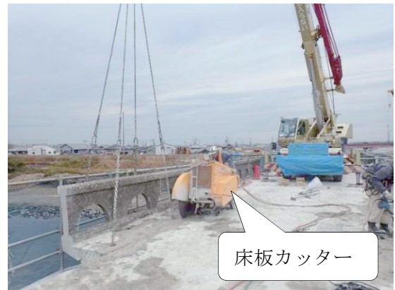
写真-2 高欄・張出し床板切断状況
