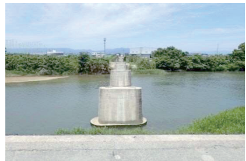
写真-9 ゲルバー桁撤去完了
