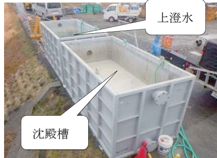
写真-7 切断水の回収と循環利
