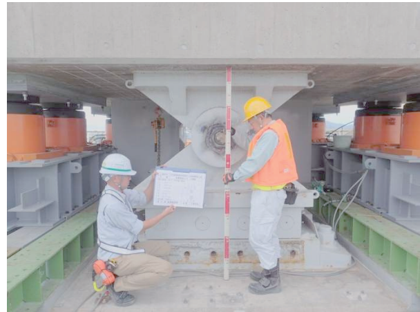
写真-1 仮受けジャッキ設置状況
