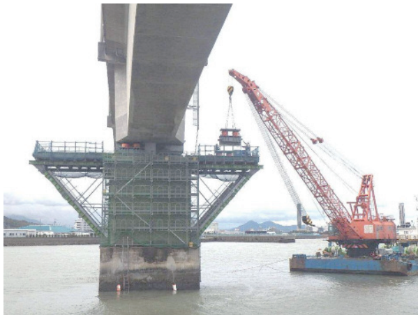
写真-2 海上橋脚施工状況
