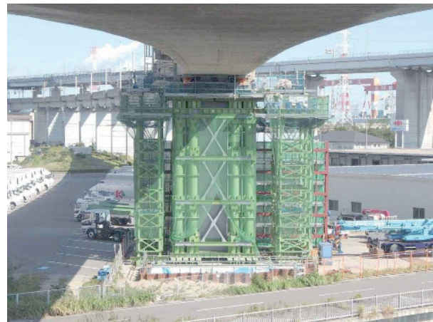
写真-3 ジャッキ設置用ベント
