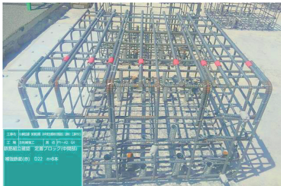
写真-1 補強鉄筋配置
