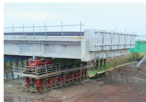
写真-5 ジャッキアップ完了
