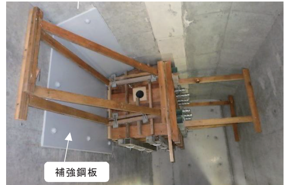
写真-2 鋼板接着による補強
