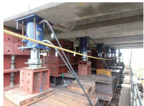
写真-2 ジャッキ設置状況 (中間ベント)
