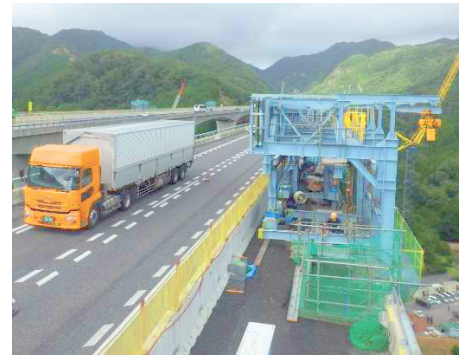
写真-1 床版拡幅台車施工状況 (上り線)
