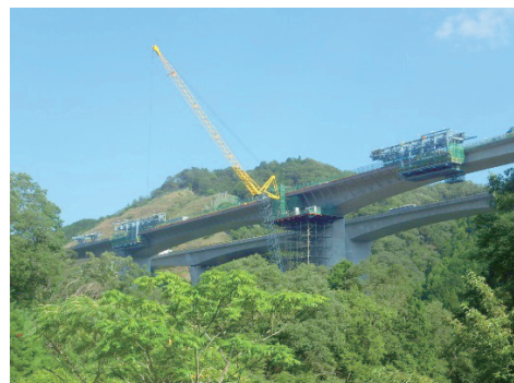
写真-1 施工台車による施工状況
