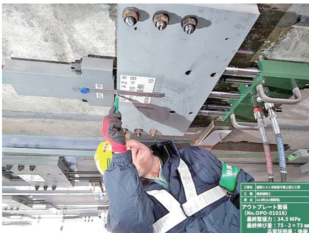
写真-3 新型ジャッキによる緊張
