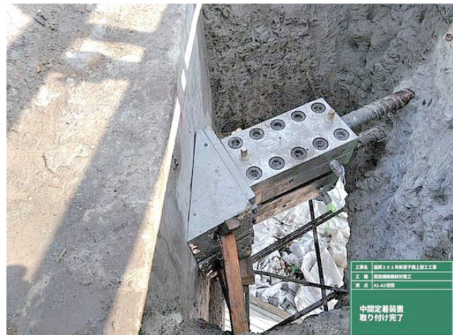
写真-7 中間定着装置の取付状況
