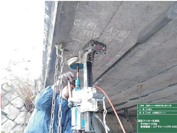
写真-1 外桁の削孔状況
