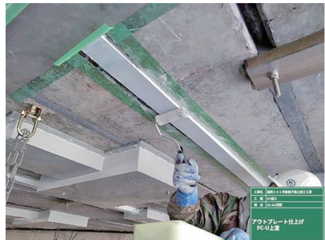
写真-6 炭素繊維プレート仕上げ状況
