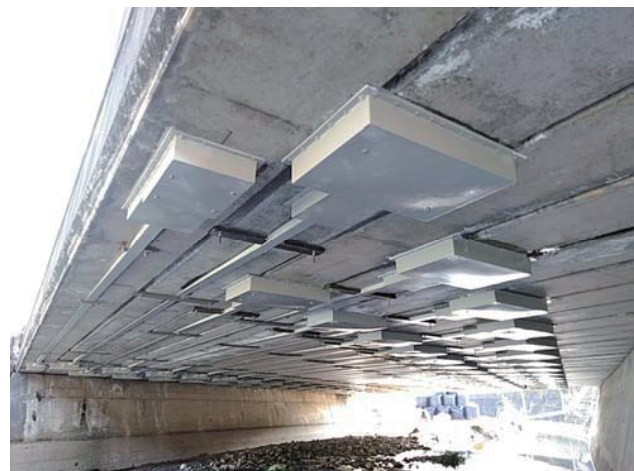
写真-8 炭素繊維プレート補強完了
