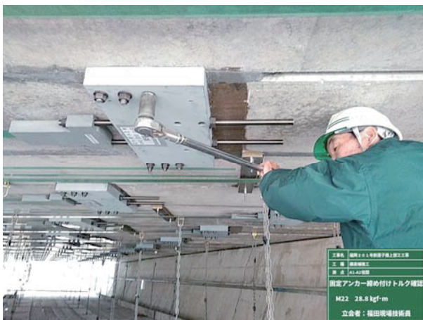
写真-2 中桁固定プレート設置状況
