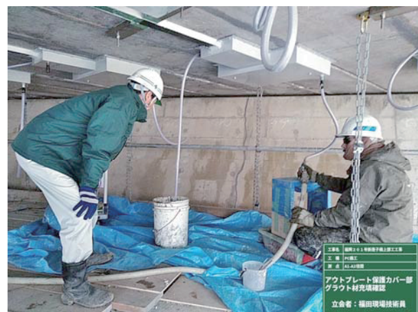
写真-5 グラウト注入状況
