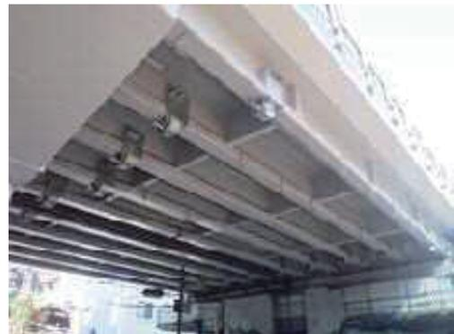
写真-3 外ケーブル補強 (全景)
