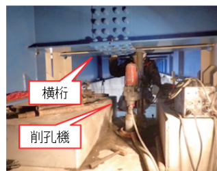
写真-4 削孔
