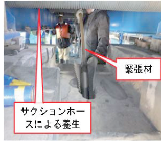
写真-6 緊張材挿入
