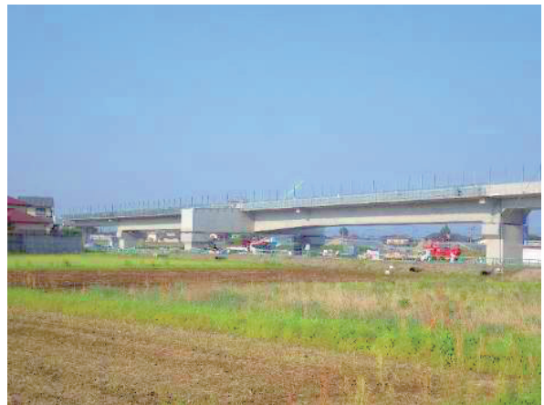
写真-2 よし川B橋りょうの全景
