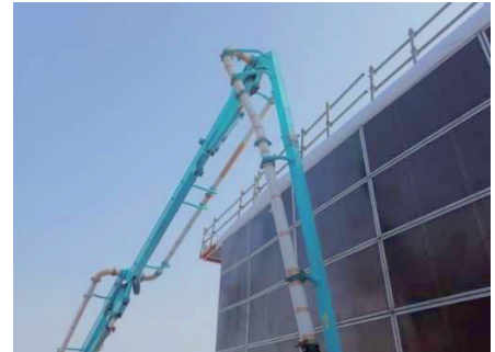
写真-6 ポンプ車断熱シート設置
