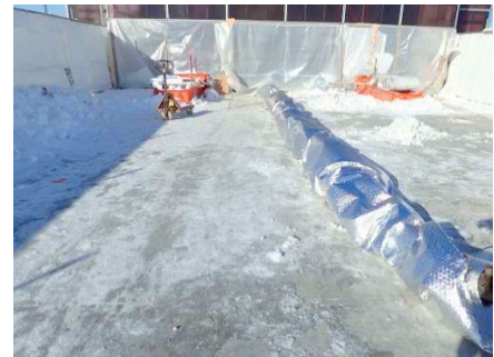
写真-7 橋面上断熱シート設置
