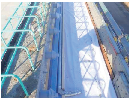
写真-11 地覆底版鋼管パイプ配置
