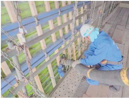
写真-1 中間投入口からの打設
