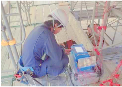
写真-4 充填・締固め確認
