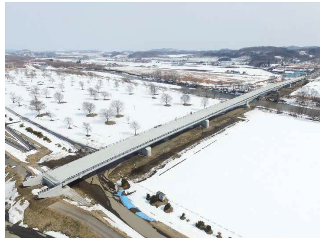
写真-13 (仮称) 見晴橋 完成
