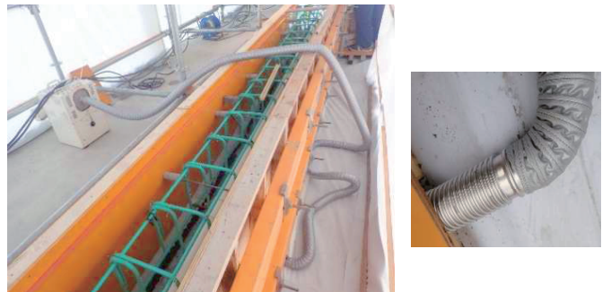
写真-12 熱風送風機による底版型枠加温状況
