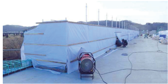
写真-10 地覆雪寒施設全景
