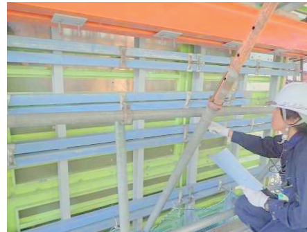
写真-2 充填・締固めの目視確認
