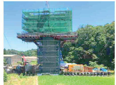
写真-1 クーリング実施状況
