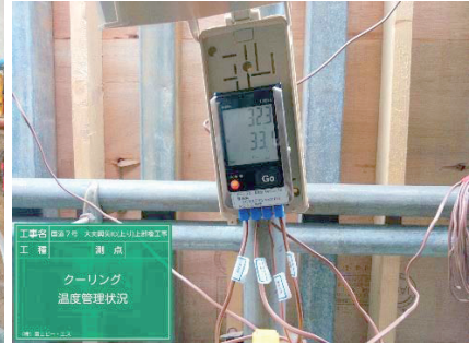
写真-3 クーリング温度管理状況
