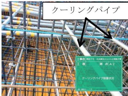
写真-1 クーリングパイプ配置
