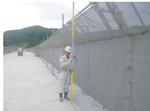
写真-5 橋面防護状況
