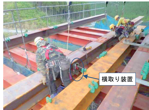
写真-4 H鋼横移動状況
