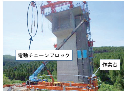
写真-3 作業台組立状況
