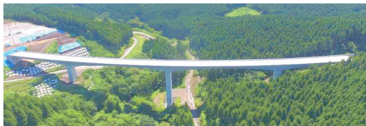
写真-6 完成写真
