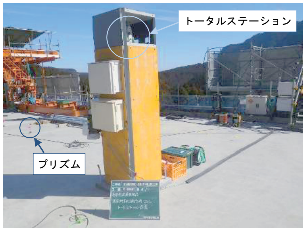
写真-1 トータルステーション設置
