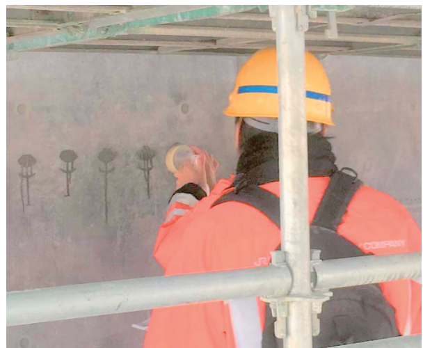
写真-2 散水試験状況
