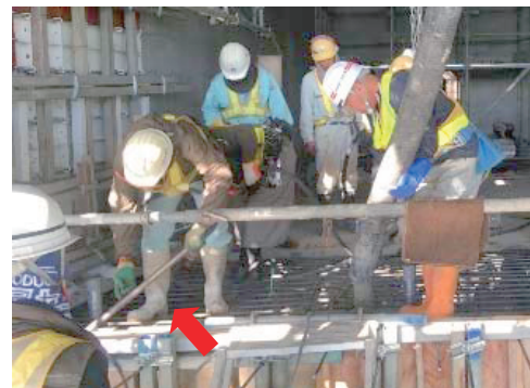
写真-1 マルチパイブレーター使用状況
