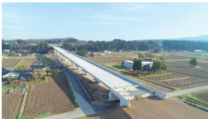
写真-6 完成写真
