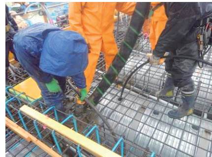
写真-2 コンクリート打設状況
