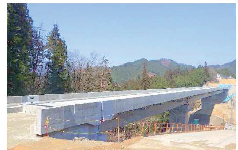
写真-7 完成写真
