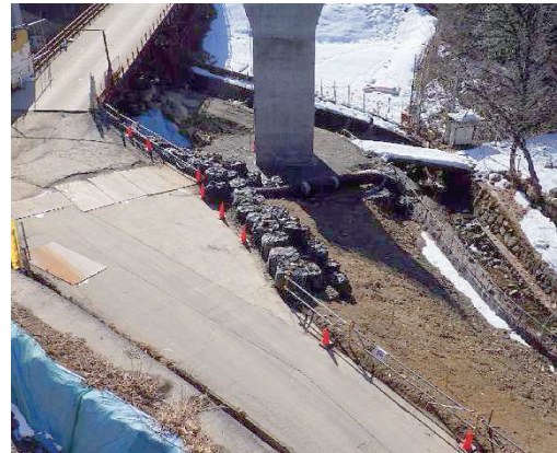
写真-5 施工前 P1 橋脚ヤード
