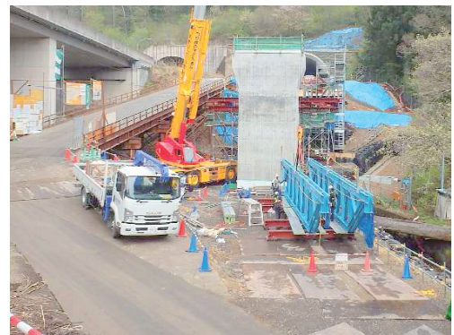
写真-6 トラス架設中 P1 橋脚ヤード
