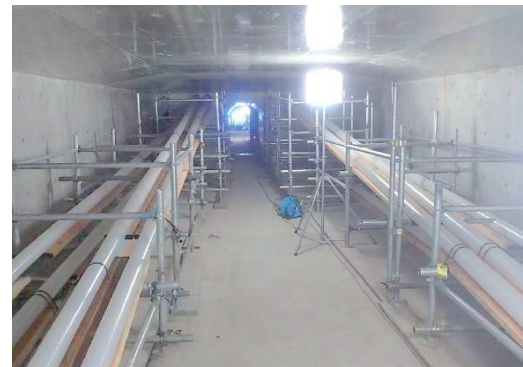
写真-3 シース配置状況
