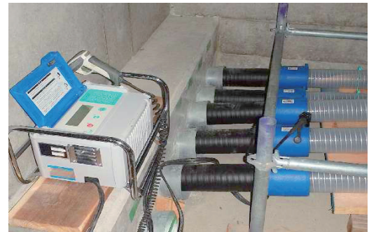
写真-2 EFジョイント接続状況
