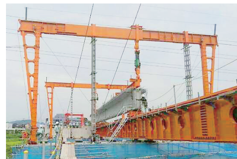
写真-4 架設状況
