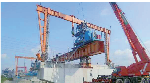
写真-1 門構送り出し (リフター)
