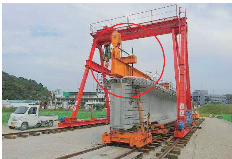
写真-3 鋼製補助桁
