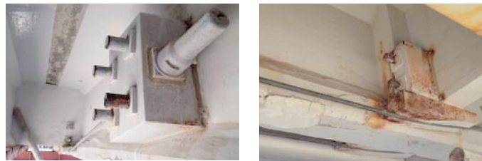
写真-1 外ケーブル補強状況 (3番, F30T)
