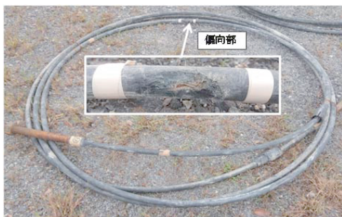
写真-3 外ケーブルの外観 (8番, F30T)
