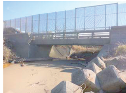
写真-1 対象橋梁の状況 (海側)
