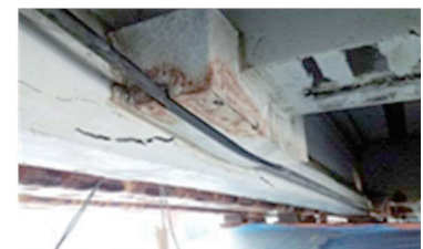
写真-2 外ケーブル設置状況
