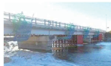
写真-1 橋梁全景
