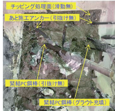
写真-3 定着部の解体状況
