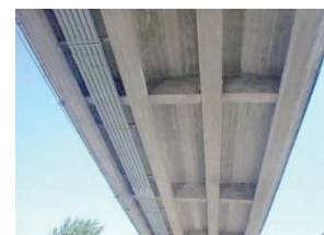
写真-3 現況写真（桁下面）
