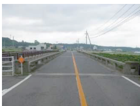
写真-1 現況写真（橋面）
