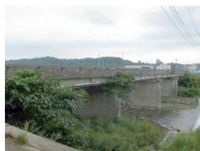
写真-2 現況写真（側面）
