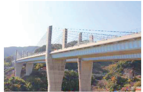
写真-1 完成写真
