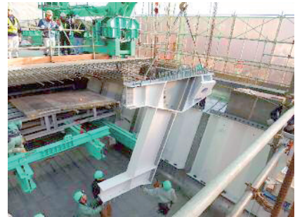
写真-4 鋼製隔壁の架設
