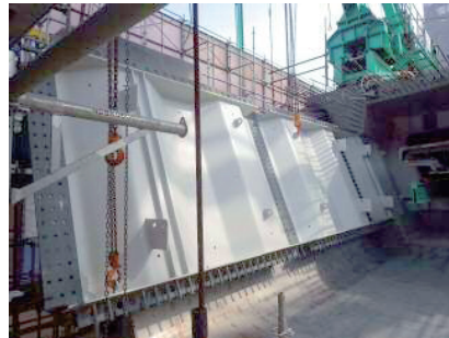
写真-3 波形鋼板の架設
