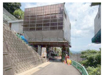
写真-9 A2支保工
