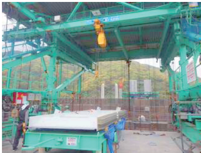
写真-2 波形鋼板の運搬状況
