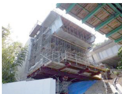
写真-8 A1支保工
