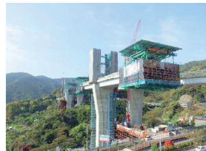
写真-5 張出し施工全景
